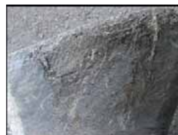
Fig. 12 - Area danneggiata / Damaged area
