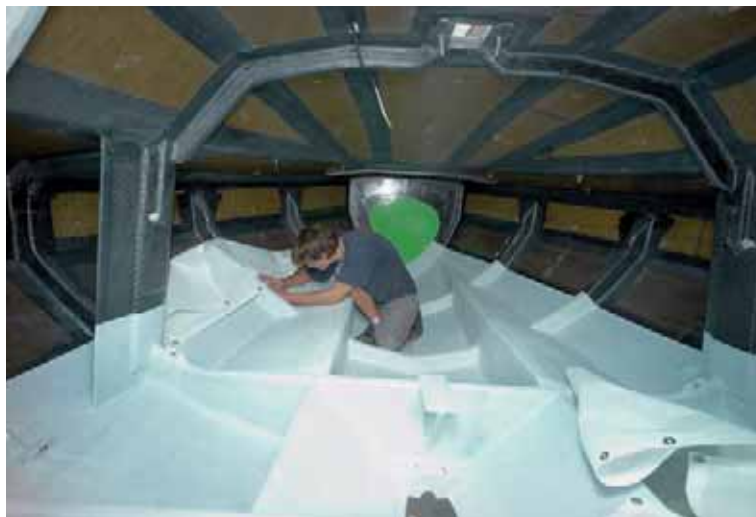
Thibault lavora all'interno dello scafo / Thibault working in the hull
