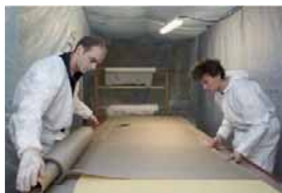
Preparazione dei pannelli sandwich preparation of sandwich panels
