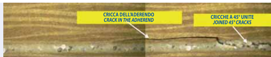
Fig. 12 - Cricche a 45° unite e propagazione nell'aderendo superiore per MM = 0.75 Joined 45°-oriented cracks and propagation in the adherend for MM = 0.75
